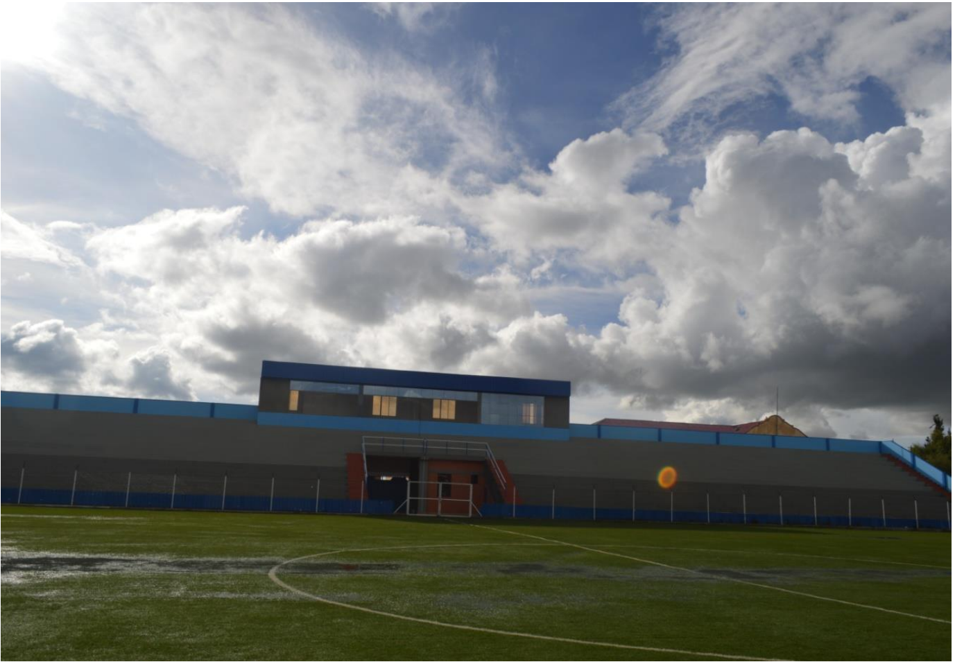
IMAGEN: PROYECTO “GRADERÍAS DEL STADIUM LAZO” – CIUDAD DEPORTIVA DE PUCARANI
