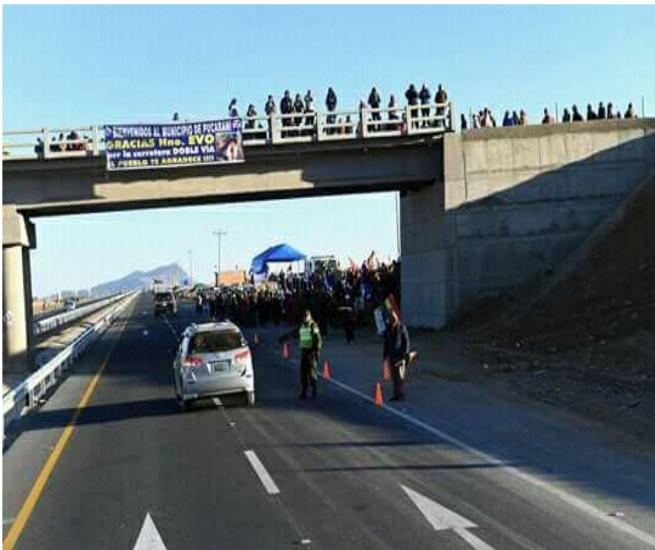
DOBLE VIA CARRETERA PANAMERICANA-RED FUNDAMENTAL (CRUCE PUCARANI)
